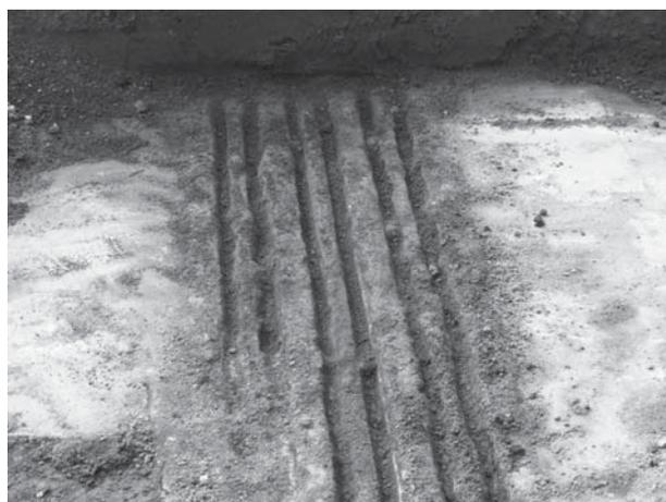
写真7 ガス管敷設工事地区検出鉄製レール
