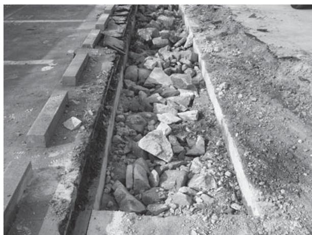
写真 9 排水管敷設工事地区検出コンクリート面基礎栗石露出状況
