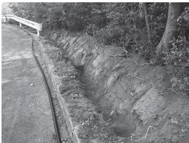
写真2 2区中央部電気配管掘り方と道路法面外灯基礎部分堆積状況
