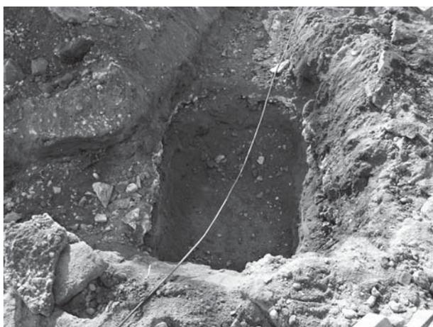
写真22 第VI地区（第52区）外灯基礎掘り方完掘状況
