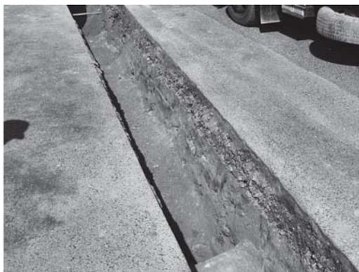
写真10 翠地区講堂東側給水管改修工事（正面ゲート付近）配管掘り方堆積状況（西壁）
