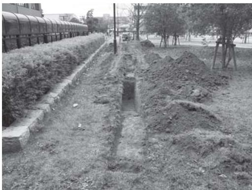
写真5 東広島地区カフェテリア建設工事電気配管地区試掘状況
