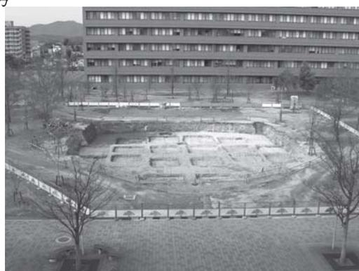
写真6 東広島地区カフェテリア建設工事基礎掘り方掘削状況
