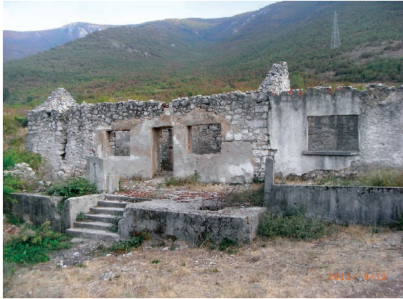
写真3 山腹に残る破壊され放置されたセルビア人住宅の住宅
