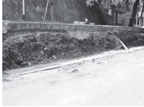
写真 33 法面南部～中央部掘削完了状況(南東より)
