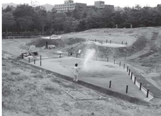
写真5 須恵器焼成窯跡復元灰原硬化剤固結のための散水状況
