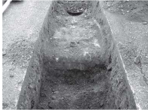
写真 16 排水管掘り方のコンクリート構築物 検出状況（北より）
