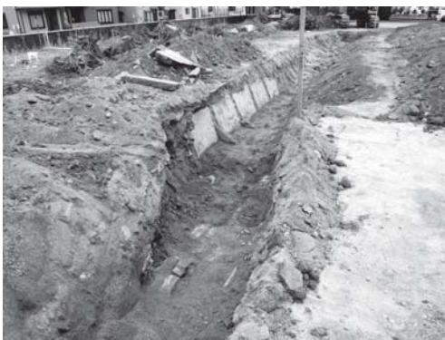
写真 30 排水管掘り方完掘状況 (東より)
