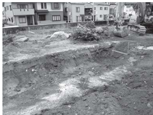
写真 31 排水管掘り方西半部完掘状況 (北東より)
