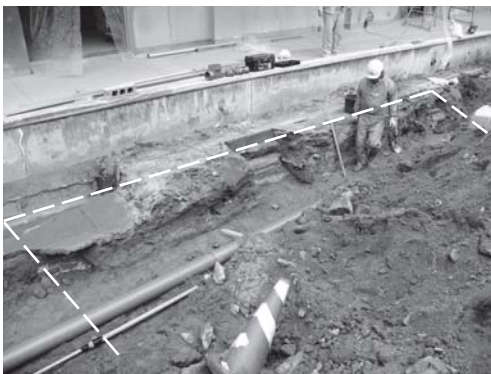
写真 22 4区東部建物基礎検出状況（南西より。破線は建物基礎の外側のライン。）
