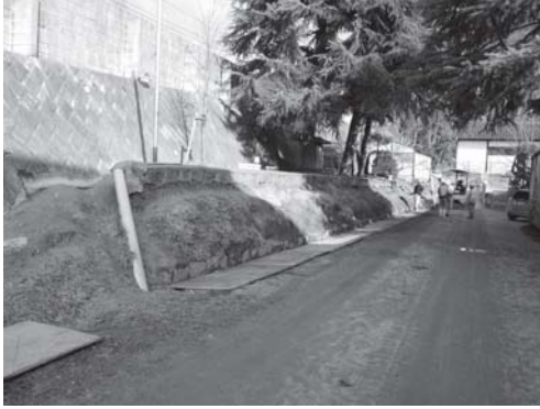
写真 32 小学校西側法面の工事前の状況(南より)
