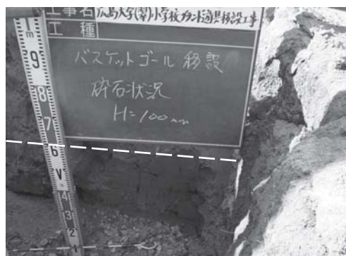
写真 17 バスケットゴール基礎完掘状況 (南より。破線より上はグラウンド造成に伴う盛土。)
