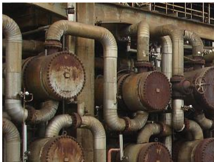
Fig. 1-2 機器および配管接続部の管フランジ締結体の例（著者（近藤）撮影）
