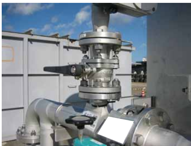
図 1.1 フランジ締結部の例
