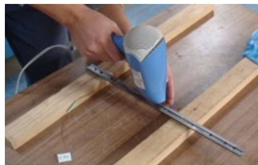
鉄筋内部の除湿
