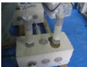
写真 2-2-4 エポキシ樹脂注入
