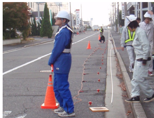
写真 6.8 計測線設置完了全景
