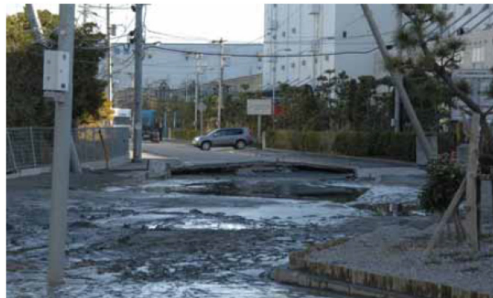
写真 2.16 千葉県浦安市千鳥地区の噴水状況 21)
