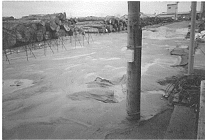
写真 2.9 函館港 万代埠頭 荷さばき地の噴砂状況 11)
