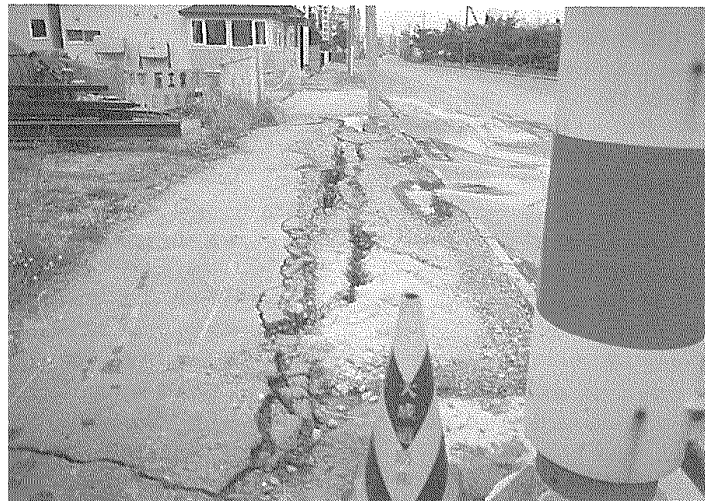
写真 2.10 函館港 北埠頭 臨港道路の亀裂 11)
