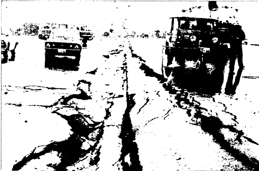
写真 2.4 中島埠頭 (-10m) における地表面の被災状況 6)
