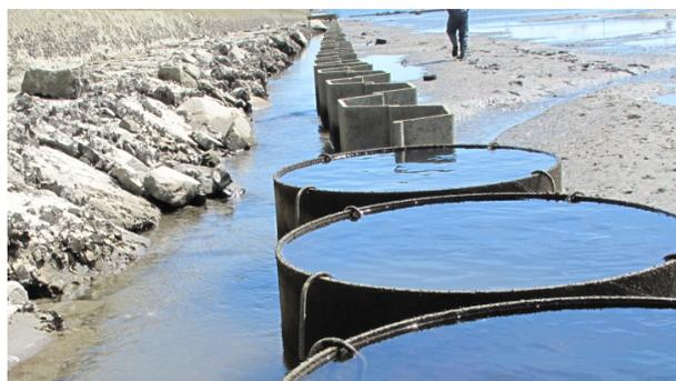
写真-5.5.1 堤内側からの不圧地下水が護岸法尻と鋼矢板の間に流出し滞水する様子<sup>47)</sup>
