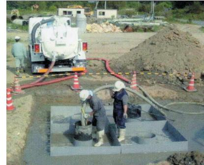
図-5.1.15 真空ポンプ工法の概要<sup>10)</sup>
