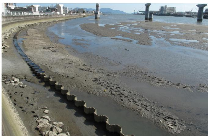
写真-5.5.2 試験対象地区の概観（鋼矢板打設後，2011年7月）<sup>47)</sup>
