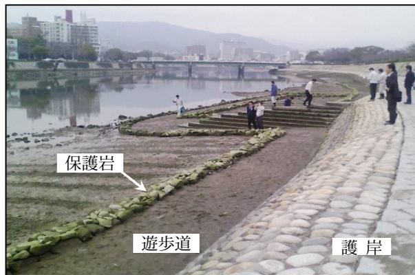
(河岸に堆積したヘドロ干潟上に地盤改良材を用いて施工 (太田川河川事務所施工))
