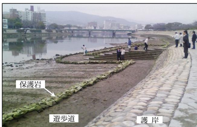
(河岸に堆積したヘドロ干潟上に地盤改良材を用いて施工 (太田川河川事務所施工))
