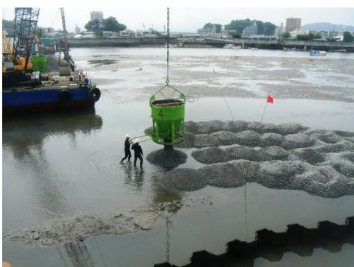
写真-5.5.3 コンクリートバケットを用いた覆砂材の投入状況
