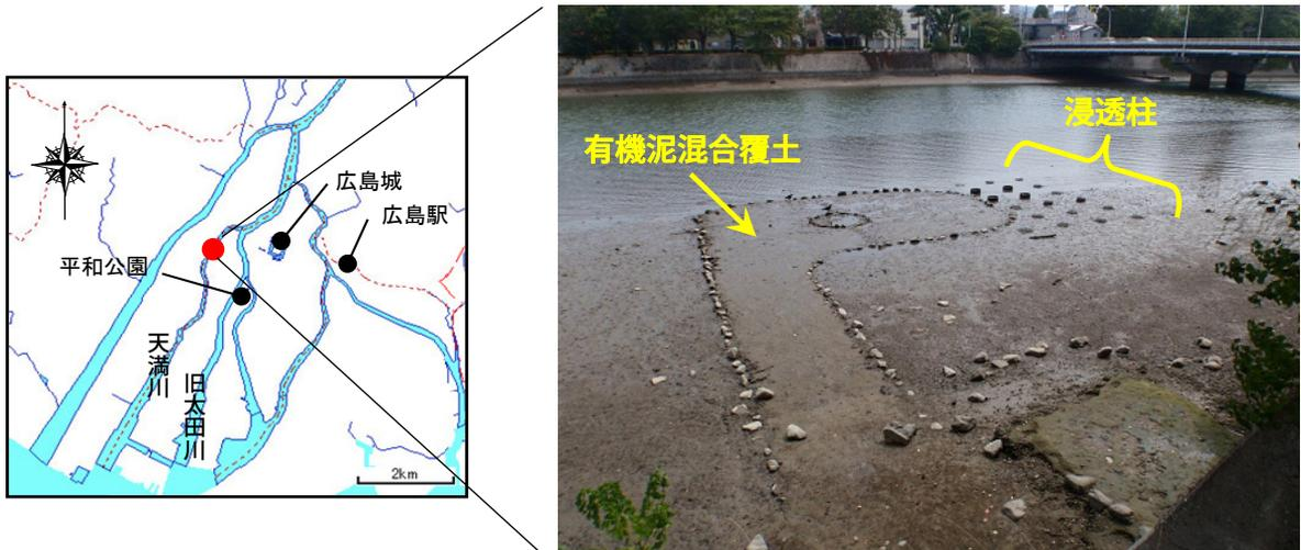
図-5.1.17 天満川中広大橋上流右岸付近の干潟と浸透柱の設置状況
