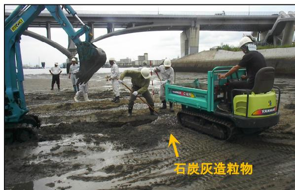
(石炭灰造粒物の溝内投入・敷き均し)
