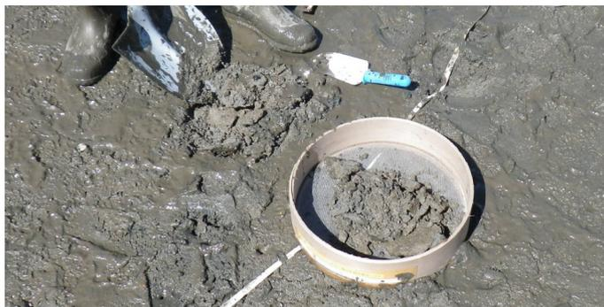
写真-5.4.5 天満川中広大橋上流右岸河岸干潟に敷設した混合覆砂の状況（2012年9月）
