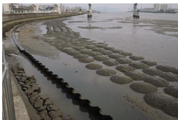
写真-5.5.4 覆砂材（石炭灰造粒物）の小山状投入完了時の状況<sup>47)</sup>
