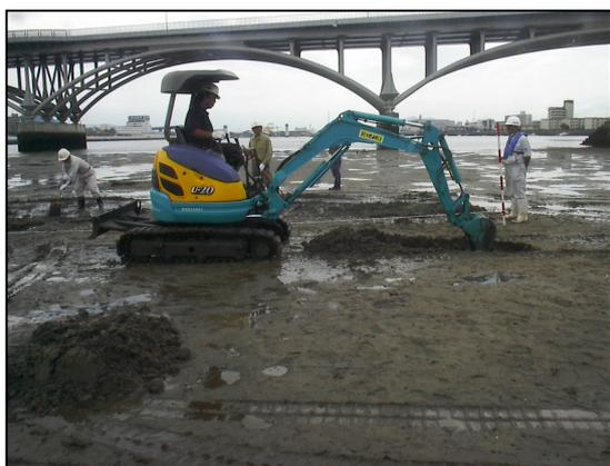
(バックホウによる溝の掘削)
