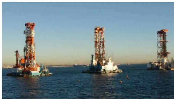
写真-4.4 CDM改良の施工状況
