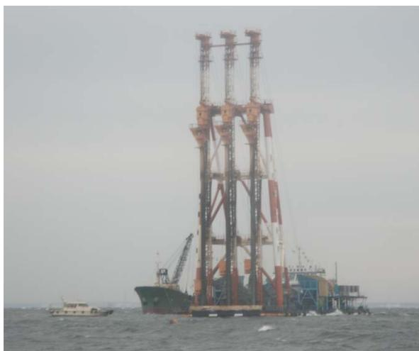
写真-4.3 SCP 打設状況
