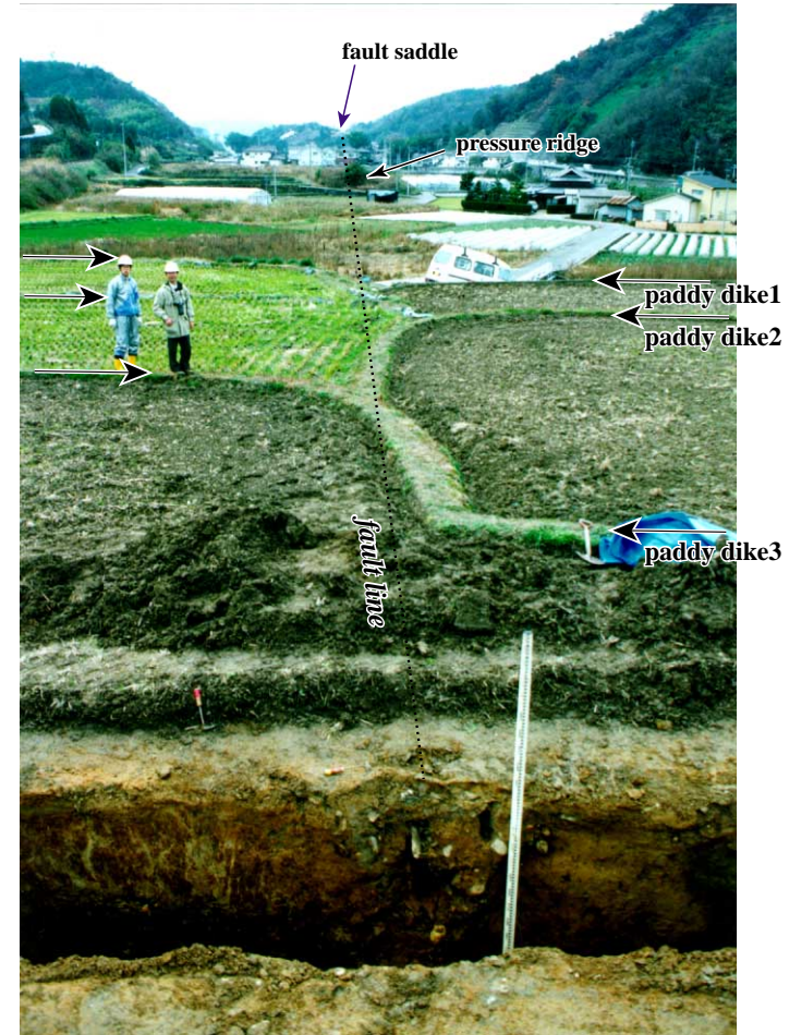
図 77-6 A トレンチ壁面に露出した断層と田の畔のずれ A トレンチの北から南西方向を撮影
