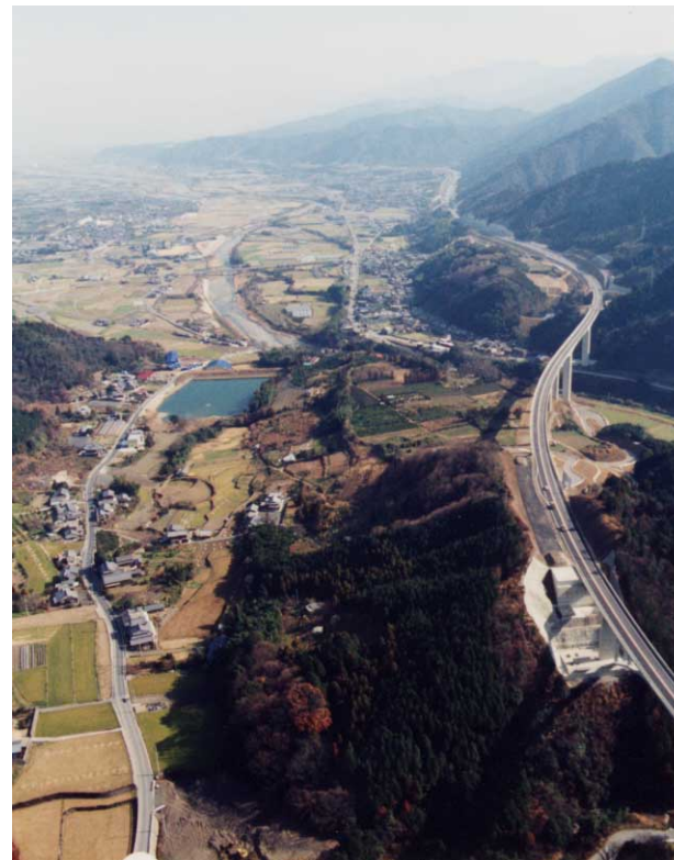
図 62-4 155.5 付近上空から北東方向を撮影 手前には、154.53 ~ 155.32 付近の低断層崖がみられる。 それより北東 (150.68 ~ 155.53) では、川上断層は中山 川の沖積面下を通過する。
