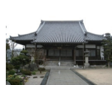
写真1 築200年の寺院建築 (過去3回改修工事歴有)
