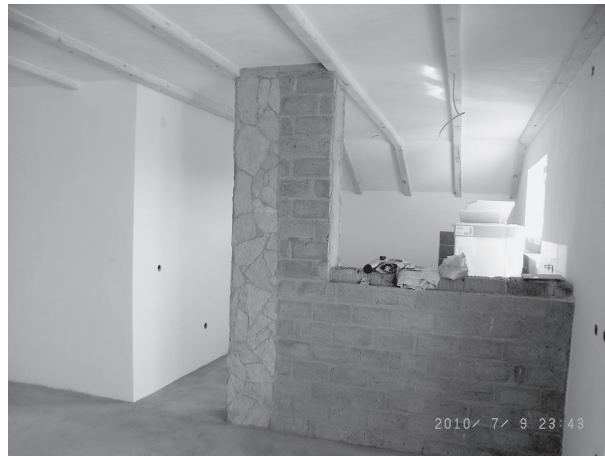
写真11 造作中の二階の部屋
