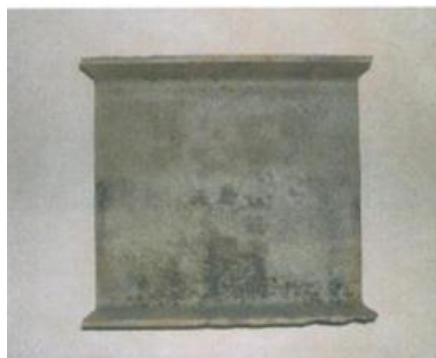
写真3.2.8 錆・塗装の除去後の状態
