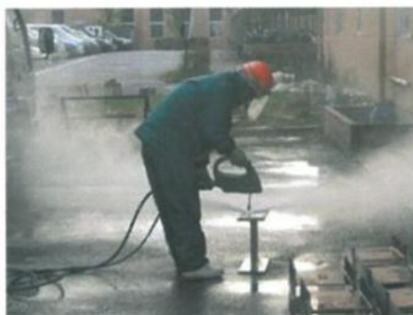
写真3. 2. 6 ウォータブリッド工法による除去状況
