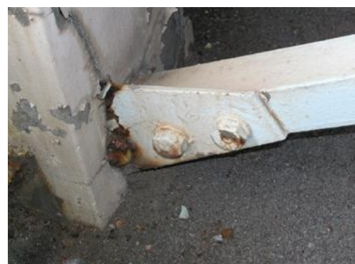
写真3.2.5 筋かい接合部の腐食状況
