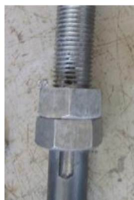
写真 2.5.6 側面貫通状況
