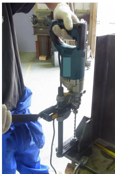
写真2.5.3 ハンドドリルによる穿孔の状況
