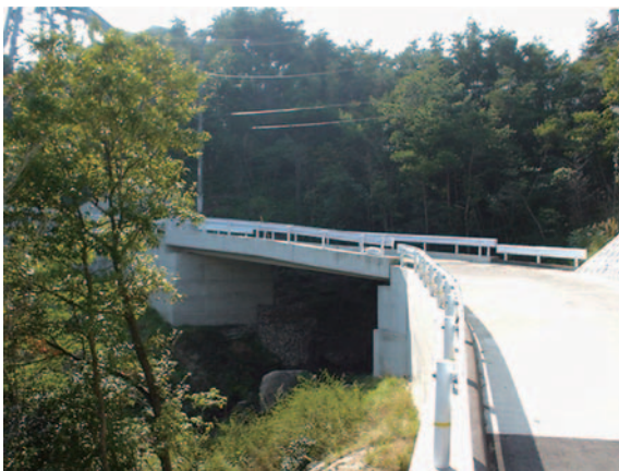
図 13 ピーク A, B 間の溪谷源頭部に建設された橋梁 2006 年 11 月撮影。油分流出防止のためコンクリート舗装を採用。左上隅にピーク A の鉄塔脚部が見える。
