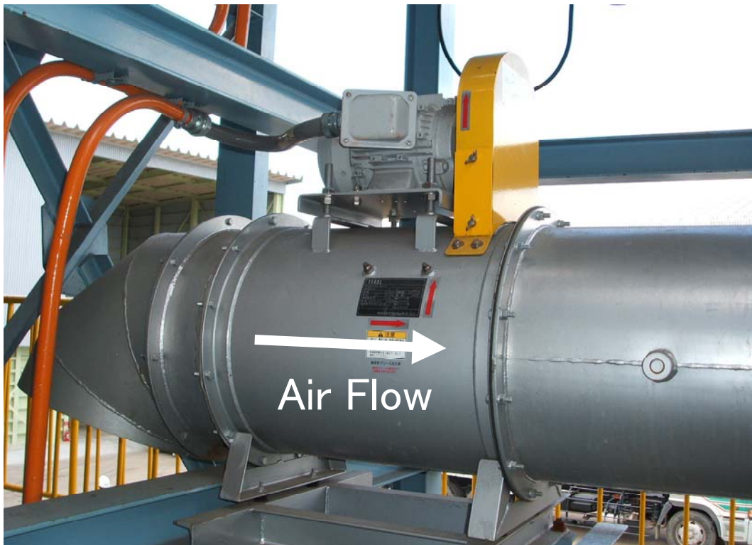
図 1.8 軸流ファンの設置例
