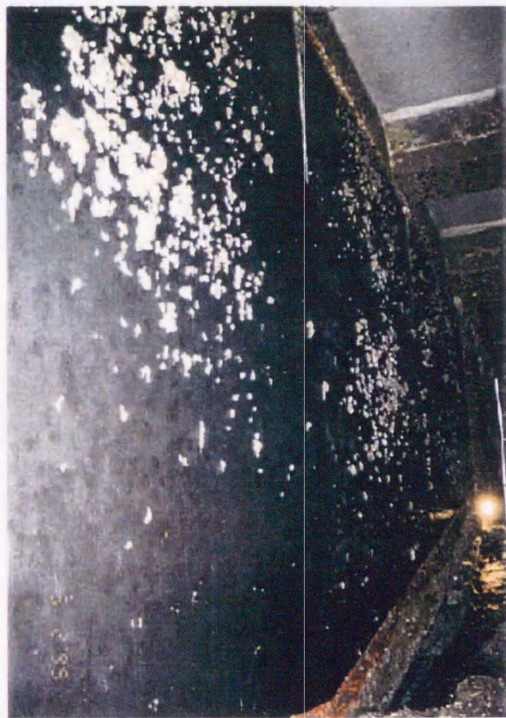
導電塗膜（A区画）
