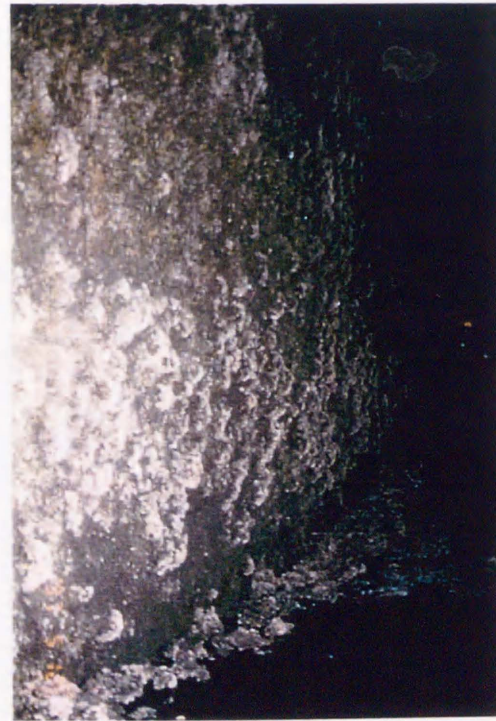
シリコン系防汚塗料面
