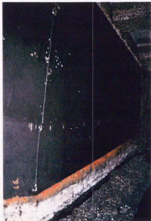
導電塗膜（A区画）
