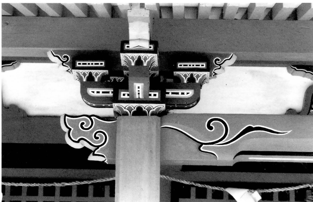
写真二 泉穴師神社本殿向拝虹梁形頭貫
