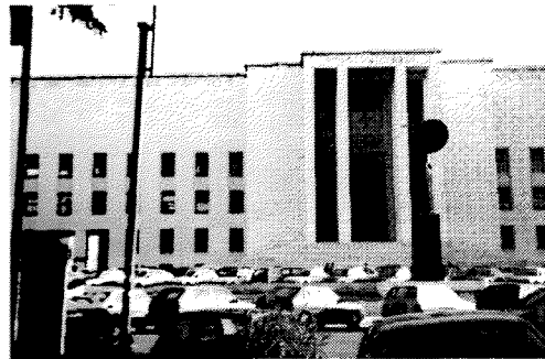
図3 正門方向から見たローマ大学都市構内の 管理棟
