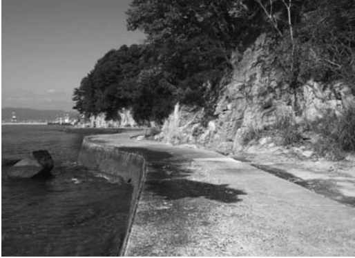
図3 整備された歩道と露頭状況
