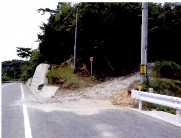
写真-4.10 道路へのわずかな土砂流出 Photo 4.10 Slight sediment discharge onto a road
