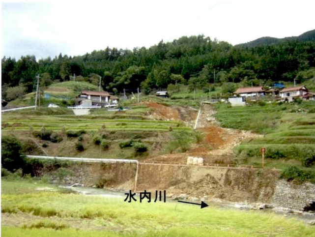
写真-4.5 中生層の塩基性岩分布域で発生し た地すべりの末端部
