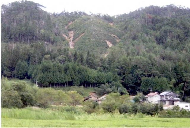
写真-4.3 風化花崗岩分布域で表層崩壊が起源 となり発生した土石流
