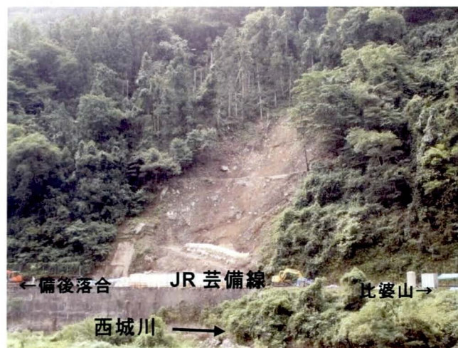
写真-4.9 庄原市西城町熊野地区で発生した崩壊
