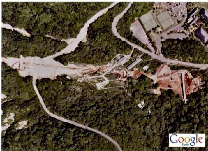
写真-4.13 箱根町湯の花沢地区で発生した土砂移動現象（Google Earthより引用）
