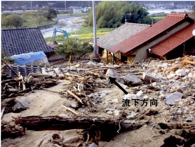
写真-4.4 土石流により全壊した家屋
