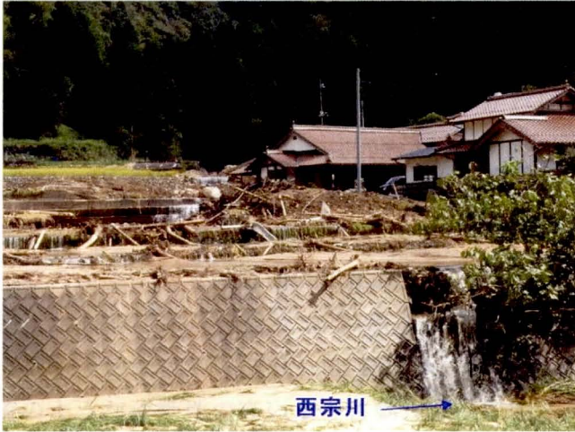
写真-4.6 風化花崗岩分布域で発生した土石流 Photo 4.6 Debris flow in a decomposed granite area 流木を含む大量の土砂が流出した。 （広島県安芸太田町穴地区， 位置は図-4.4 の E 位置付近）
