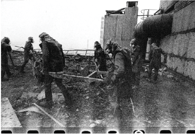
写2. 建屋の屋上に飛び散った原子炉破片の片づけ作業。彼らは“バイオロボット”と呼ばれた。
