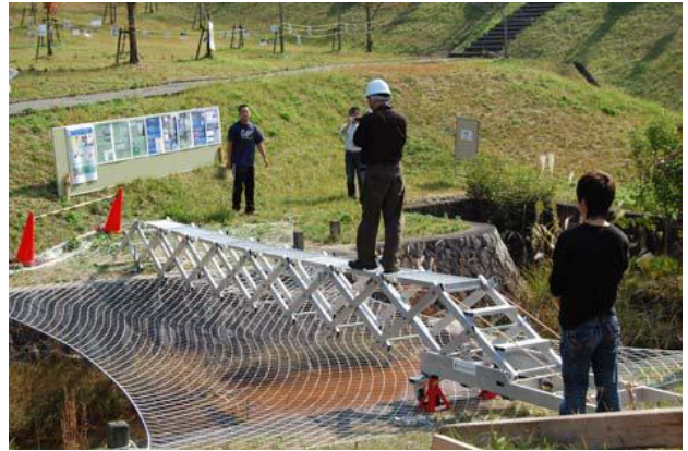
(b) 架設後の渡橋の様子
