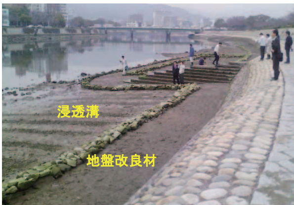
図4 旧太田川空鞆橋下流ヘドロ上に施工された遊歩道、前面は浸透溝(浸透柱の改良型)
