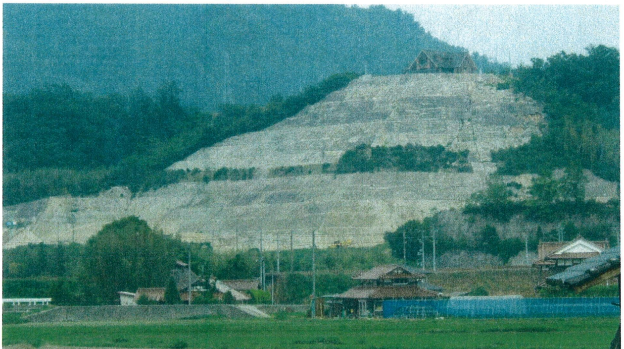
写真 1-1 崩れかけたまま異常変位が停止した状態の切土斜面 (広島県三原市河内町入野地区。2006 年 6 月 12 日撮影)
