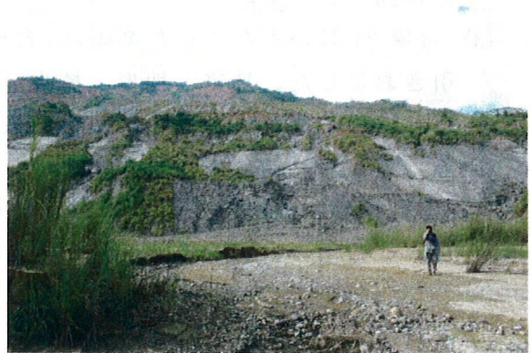
写真 5-13 九分二山の大規模崩壊脚部に見られる押出しによる破碎(2004年12月27日撮影)
