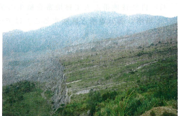
写真 5-15 草嶺の大規模崩壊の末端部に見られる崩落(2004年12月29日撮影)
