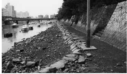
干潮時の本川橋～西平和大橋の右岸
