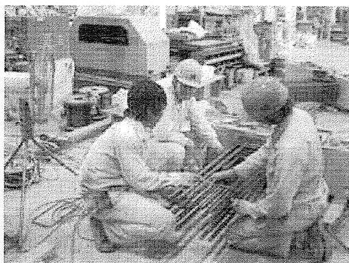
写真-4-3-3-I 梁横補強筋配
