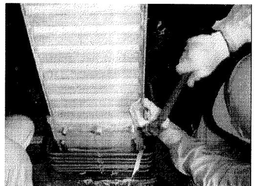
写真-4-3-2-IV コア型枠脱型
