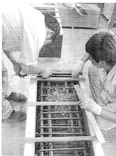
写真-4-3-3-III 梁型枠設置
