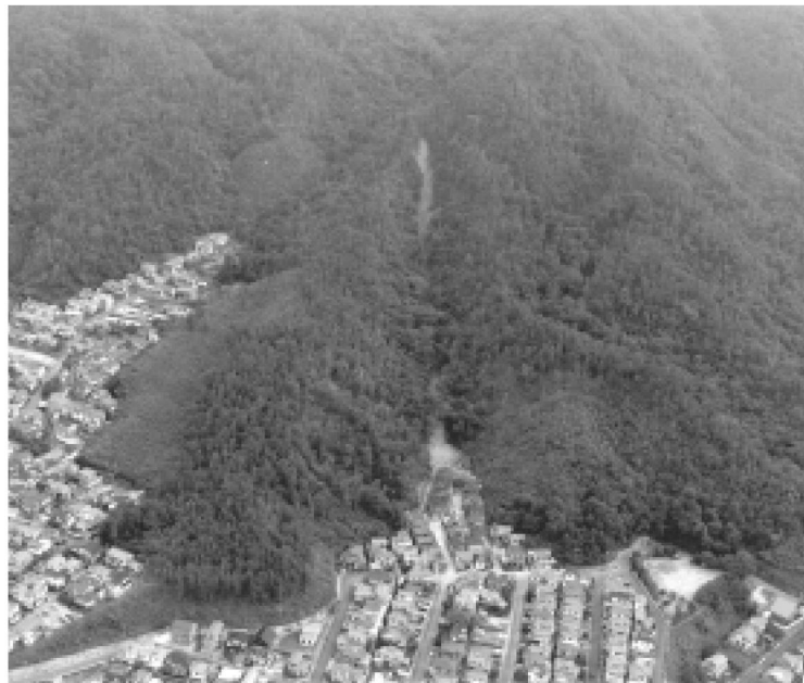
写真-1 広島市安佐南区安川支川での土石流災害（1999年6月29日発生） 小規模な土砂移動ながら1名が犠牲になった（広島県提供写真）。
