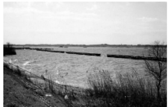
図7 土浦市沖宿付近に設置された粗朶沈床 (2006年3月25日筆者撮影)
