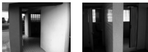
図14 中央公園のトイレの設備
