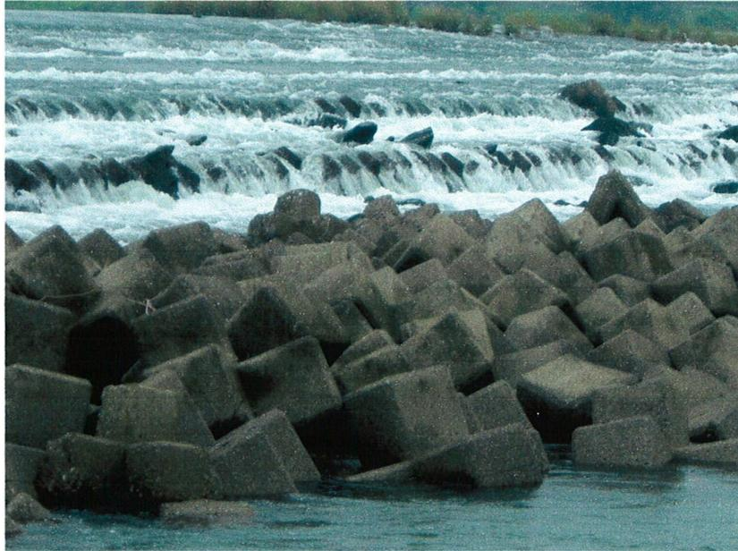
写真-1.3 護床ブロック群(吉野川)
