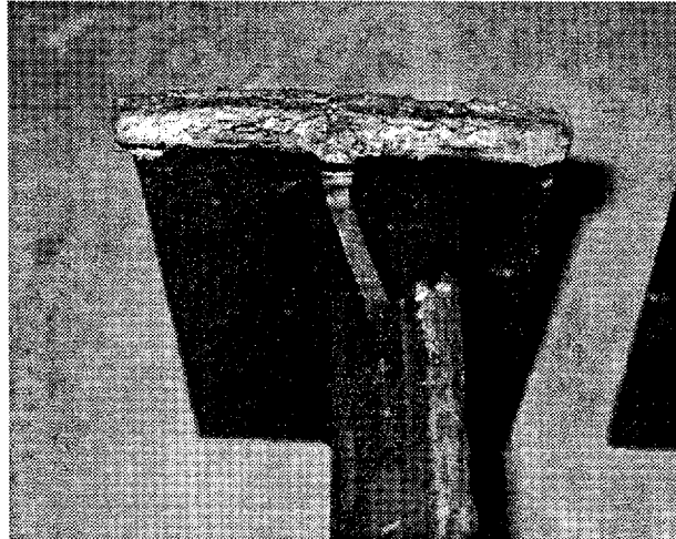
(b) タイプB [完全切断]のフランジ切断面
