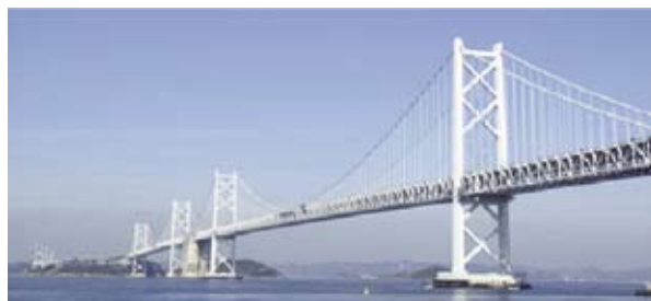
道路鉄道併用橋では世界最長の瀬戸大橋
