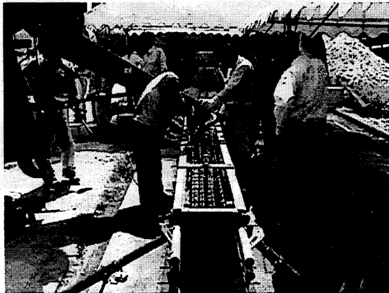
写真 4-4 コンクリートの打設
