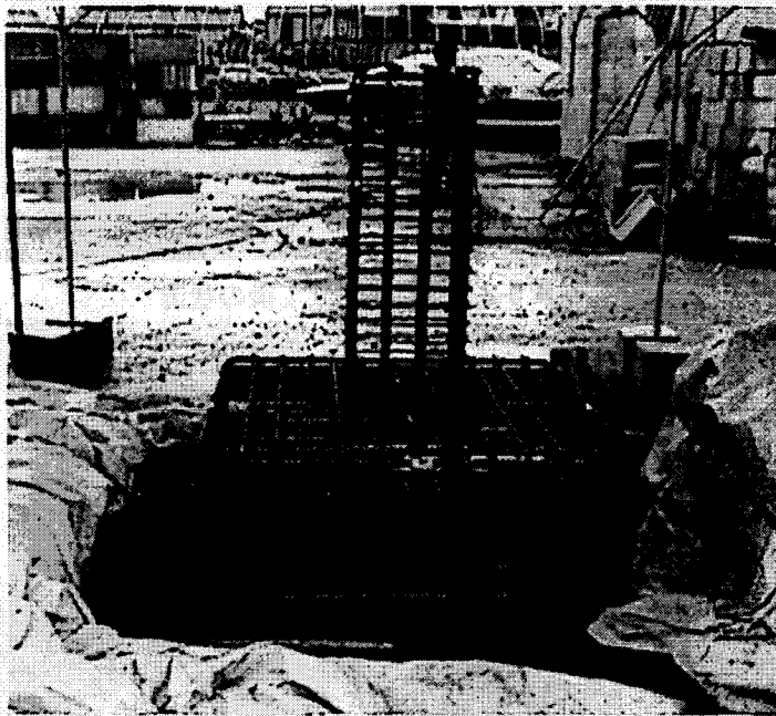
写真 5-1 組み立て後の試験体用の鉄筋
