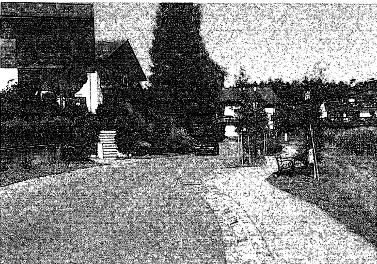
写真C-3 ムッターズ村のドルフエアノイエリング事業実施箇所。直線道路をやや狭くし、かつ屈曲させている。それによって空いた面積を歩道や緑地にあて、さらに街路樹の植栽とベンチの設置を行った。(著者撮影)
