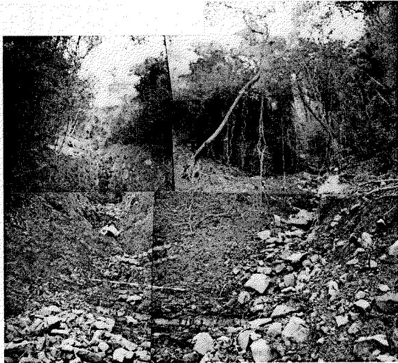
写真6 大野原町の土石流源頭部崩壊地の直下部 溪床にはいぜんとして部分的だが岩盤の露出が見られる。礫質土壌である。崩壊地勾配は34°、広葉樹を主とした自然林地帯での崩壊である。
