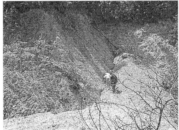
写真7 崩壊地；大規模な割れ目に沿った崩壊現場 伯方島
