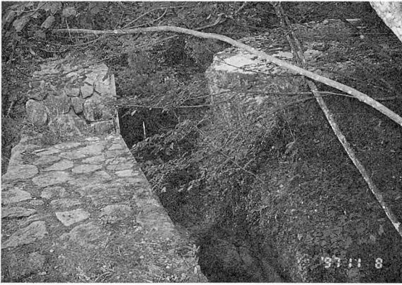
写真5 通常砂防9号堰堤には巨石を固定する目的がある
