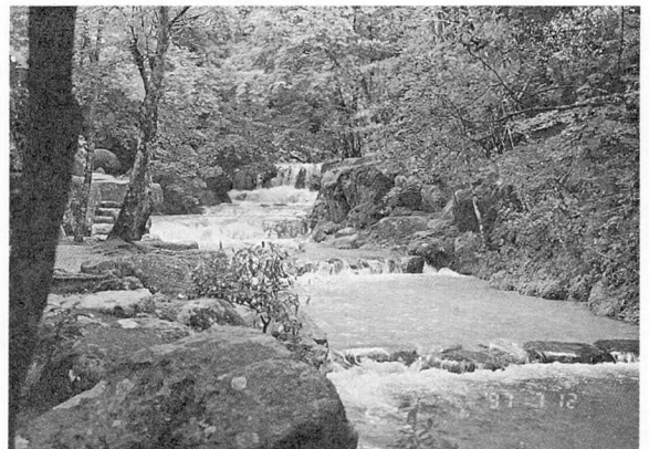
写真7 庭園砂防下流部の階段工。ここでも水量は多いが水は澄んでいる。
