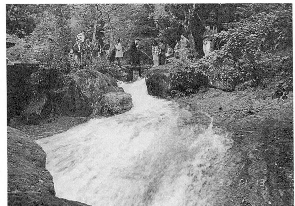
写真4 せき板をはずし岩盤上に扇形的水流を形成させる
