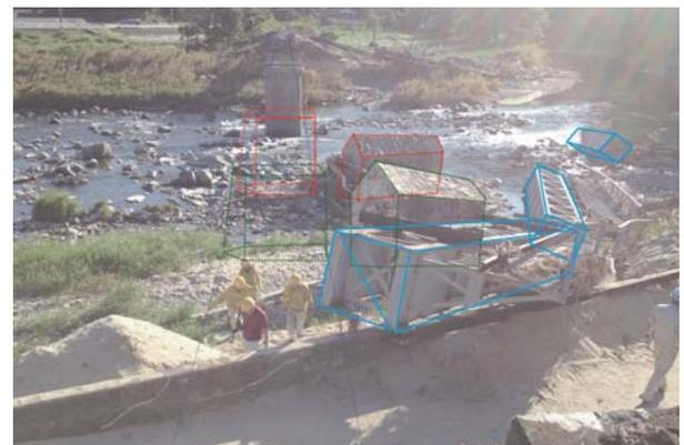
図-25 被災した第1三篠川橋梁の橋桁と橋脚の位置関係
