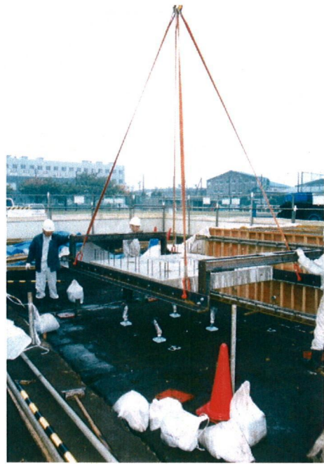
写真 3.9 RC版設置状況
