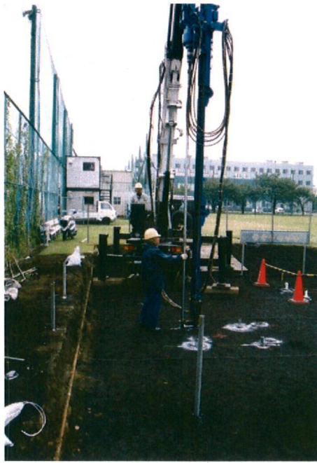
写真 3.8 杭の施工状況
