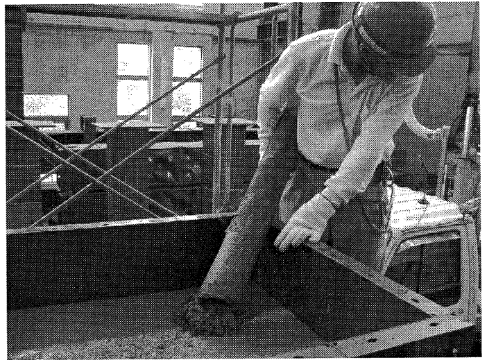
写真 2-2 コンクリート打設の状況
