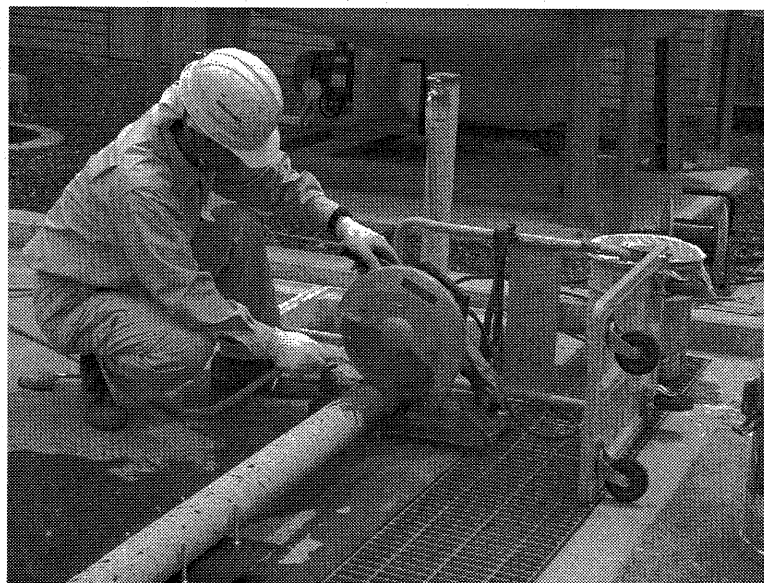
写真 2-5 コア抜きした長円柱をダイヤモンドカッターにて切断
